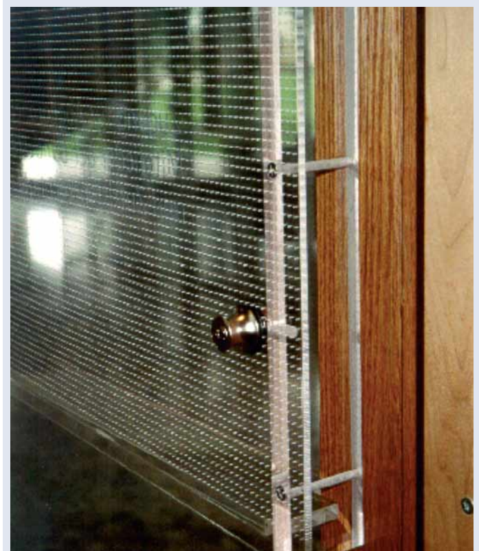
Abbildung 1: Mikroperforierter Absorber (MPA), bestehend aus einer 5 mm dicken Acrylglas-Platte mit einer Vielzahl sehr feiner Bohrungen, montiert in einem bestimmten Abstand vor einem schallharten Hintergrund. In Deutschland kam ein transparenter Schallabsorber dieser Art erstmals 1993 zum Einsatz im Plenarsaal des Deutschen Bundestages, und zwar unter der wissenschaftlichen Regie des Fraunhofer-Instituts für Bauphysik (IBP), Stuttgart.
