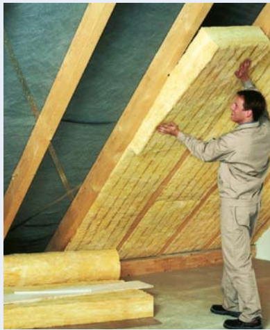
Abbildung 3: Geeignetes und fachgerecht eingesetztes Dämmmaterial bietet immer noch die beste Voraussetzung für einen guten Schallschutz, auch bei Dachwohnungen. Hier wird passend zugeschnittener Zwischensparren-Klemmfalz zwischen die Dachsparren geklemmt, wobei auf fugendichten Anschluss der Platten untereinander zu achten ist.
